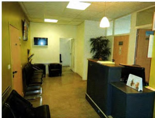
Le plafond est un faux plafond composé de dalles dans lequel est encastré des pavés lumineux et des bouches d'aération.
