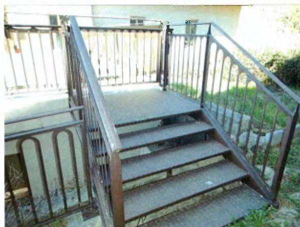
L'accès au local boîte aux lettres s'effectue grâce à une passerelle métallique accrochée directement au mur pignon de la façade Sud.
