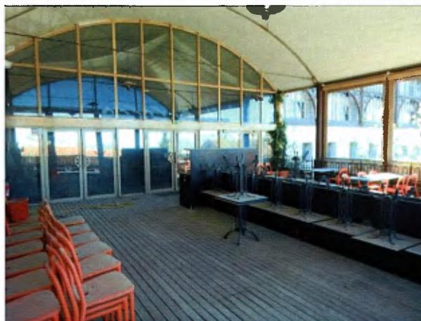
La toiture voutée est composée de plaques métalliques.
