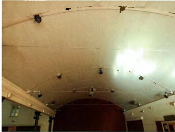
Plusieurs spots sont accrochés à la structure de ce plafond, qui par ailleurs est maintenu par quatre colonnes acier.
